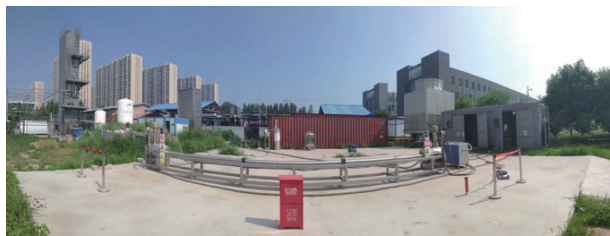
图3 10 m长10 kV/1 kA超导直流能源管道测试现场
