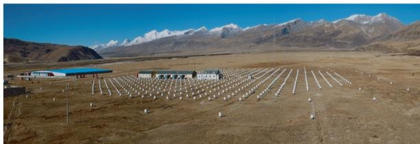
图3 我国西藏羊八井宇宙线实验基地,图中左边蓝色大屋顶是中意合作的ARGO实验大厅,白色的探测器阵列是中日合作的AS $\gamma$ 实验
